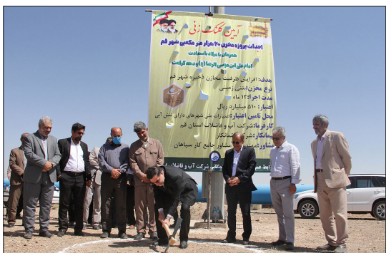
کلنگ زنی مخزن ۲۰ هزار متر مکعبی آب پردیسان
